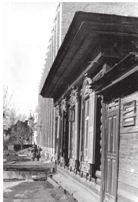
На месте, где стояла студия ишимского радиовещания, строится новое здание РУЭС. Середина 1980-х гг.
