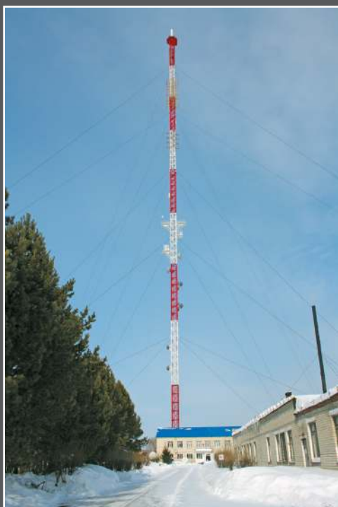
РТС высотой 246 м в Шабаново Омутинского района
