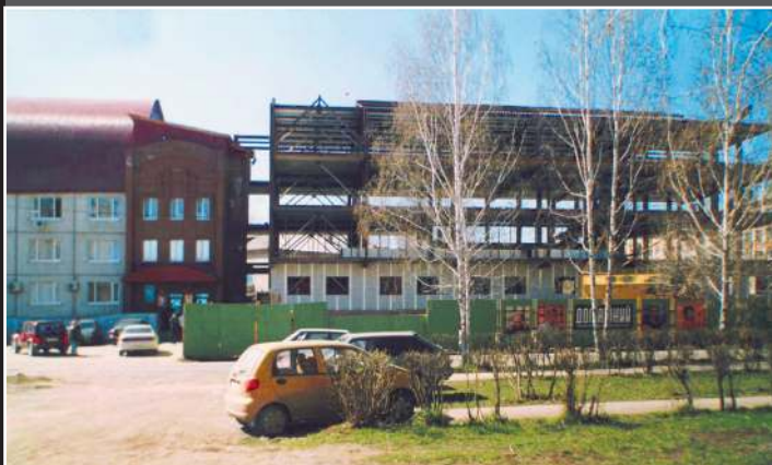
Строительство собственного здания на пр. Геологоразведчиков, 28-а
